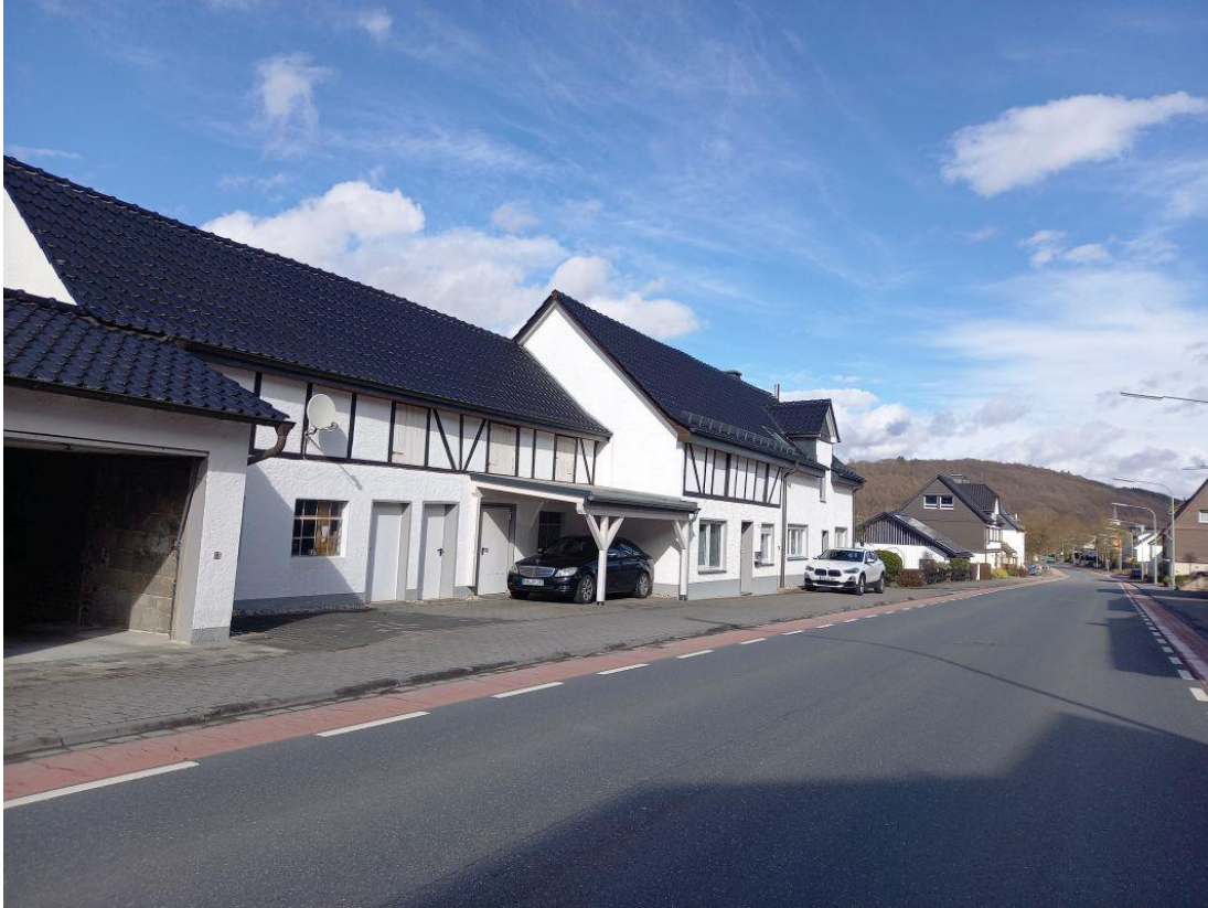
Abb. 10 Wohnbebauung entlang der Caller Straße im Süden des Plangebietes.
